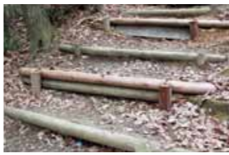
地域の人たちが協力して階段を修理! 子供たちは安全に遊べます。
