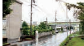
下街道に架かる歩道橋
