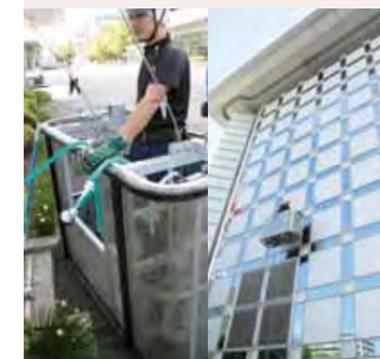
文化フォーラム春日井の軒をよく見ると、何やらレールのようなものが見えます。実はこれ、ガラス清掃用のゴンドラを吊るレールなのです。「ちょっとした風が吹くだけでゴンドラが揺れて危険ですが、そこで見える景色は最高のご褒美ですよ」と語る梅木美装さん。手元のモーター操作盤でスルスルと上昇。シャッターを駆使しガラスを丁寧に磨きます。しかし左右の動きは手動のため、地上にいる作業員さんはゴンドラをロープで引っ張る重労働です。清掃のおかげで今日も太陽の光を受けてピカピカに輝く、文化フォーラム春日井でした。
